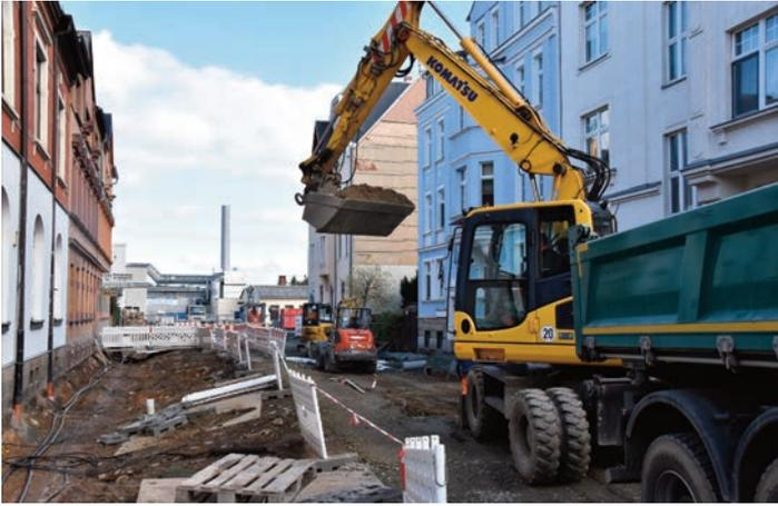
Bis voraussichtlich 20.12.2019 werden umfangreiche Arbeiten zur Rohrnetzauswechslung Trinkwasser/Mischwasser einschließlich der Hausanschlussleitungen sowie dem grundhaften Straßen- und Gehwegausbau unter Vollsperrung ausgeführt.
