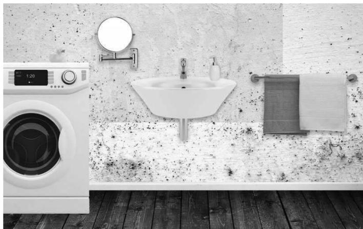
„Im Winter sind die Außenwände der Häuser und Wohnungen kalt. Auch die warme Raumluft kühlt sich dort ab. Mit sinkender Temperatur geht die Aufnahmefähigkeit der Luft für Wasserdampf deutlich zurück, so dass an der Oberfläche der Wand die relative Luftfeuchte stark ansteigt. In diesen Bereichen mit besonders hoher Luftfeuchtigkeit findet der Schimmelpilz ideale Wachstumsbedingungen vor – auch ohne fühl- oder sichtbares Kondenswasser“, erläutert Schwarzbald.
